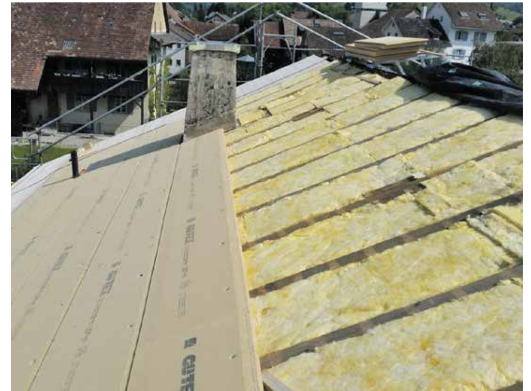
Zu den vom Energiepaket geförderten Massnahmen gehört auch die Isolation von Dächern.
