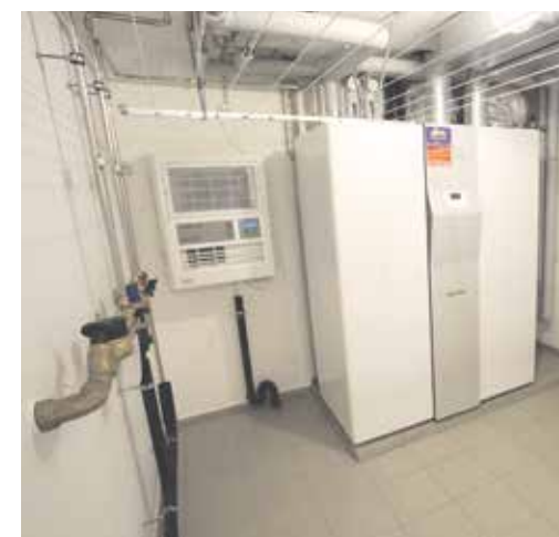
Leo Crapisi (unten) von der Gimag AG baut Häuser, die energieeffizient und gleichzeitig erschwinglich sind. Im Keller des Einfamilienhauses in Buus steht die Energiezentrale (oben), welche die Zusammenarbeit von Wärmepumpe und Photovoltaik steuert.
