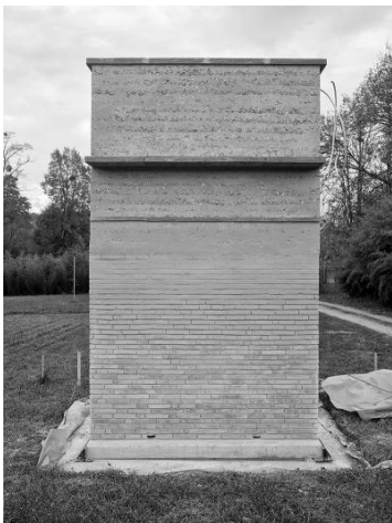
1:1 Fassaden-Mock-up im Zoo Basel
